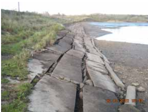
Капитальный ремонт гидротехнических сооружений на реке Локна в районе населенного пункта Бородино Фото из архива сайта orel-region.ru
