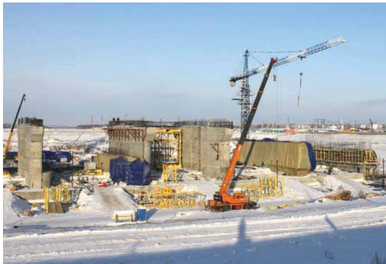
Строительство гидроузла. Фото из архива сайта proshin.info
