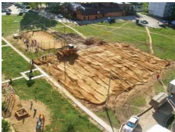
Работы по подготовке строительства автостоянки Фото из архива сайта ulgrad.ru
