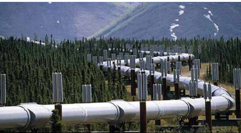
Газопровод на плато Укок. Фото из архива сайта neftegaz.ru
