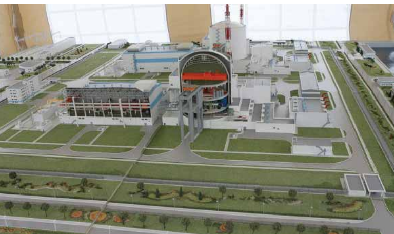
Проект строительства Балтийской АЭС Фото из архива сайта publicatom.ru
