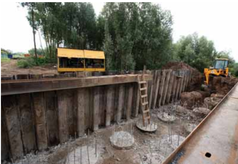
Строительство третьего моста через реку Волхов идет полным ходом Фото из архива сайта imho.novgorod.ru
