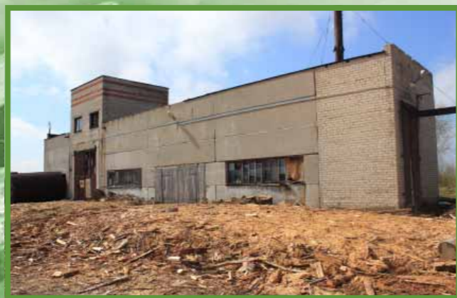
Котельная п. Хелюля
