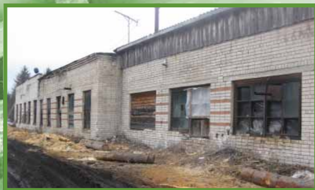
Котельная п. Пуйккола
