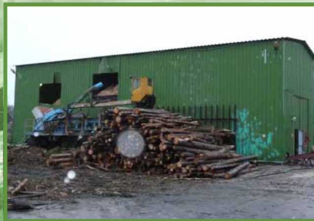
Котельная п. Ляскеля
